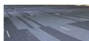
PODNA RASVJETA led linjska rasvjeta u metalnom okviru ugrađena u kamenu plohu trga
